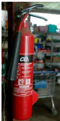
Aparati za gašenje požara trebali bi biti postavljeni tako da budu pri ruci.
