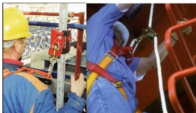
Slika 21. Primjer vertikalnog sustava za zaustavljanje pada
