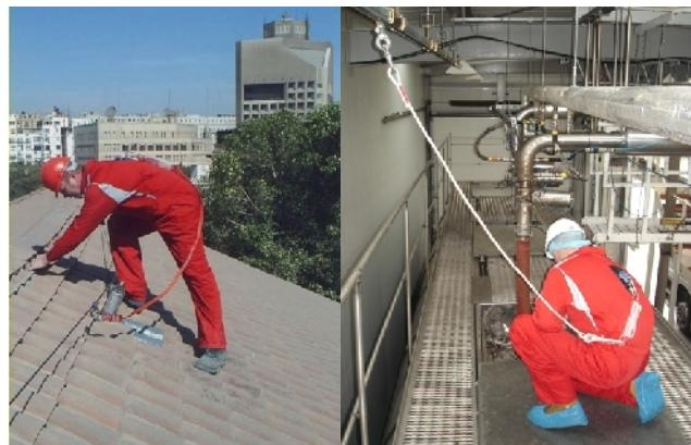
Slika 20. Primjer horizontalnog sustava za zaustavljanje pada
