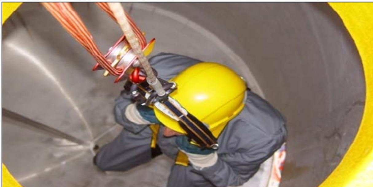
Slika 26: Ulazak u silos s opremom za rad na visini
