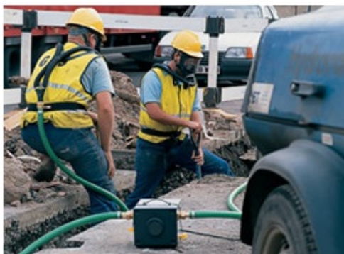
Slika 14. Cijevni uređaj s dovodom čistog zraka pomoću puhala ili mijeha
